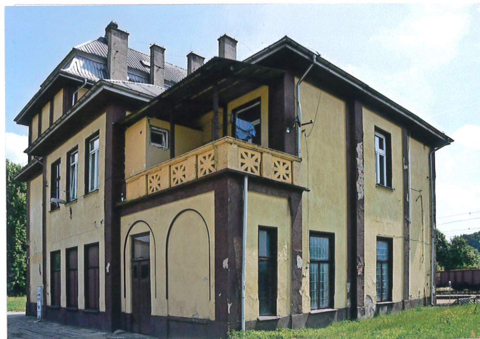
Fot. 3. Elewacje północna i zachodnia, 2019.
