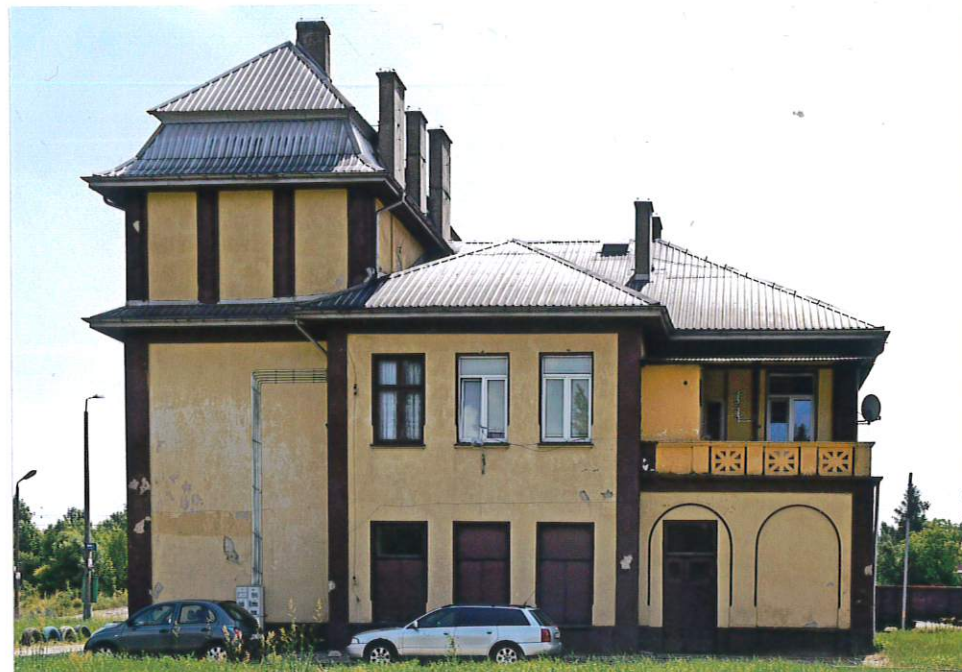
Fot. 2. Elewacja północna, 2019.
